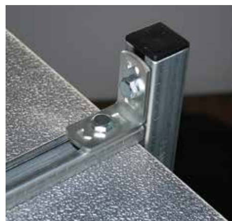
Kopse kant kanalen afgewerkt met aluminium bescherm laag + afdichtingsband t.b.v. water- en luchtdichtheid.
